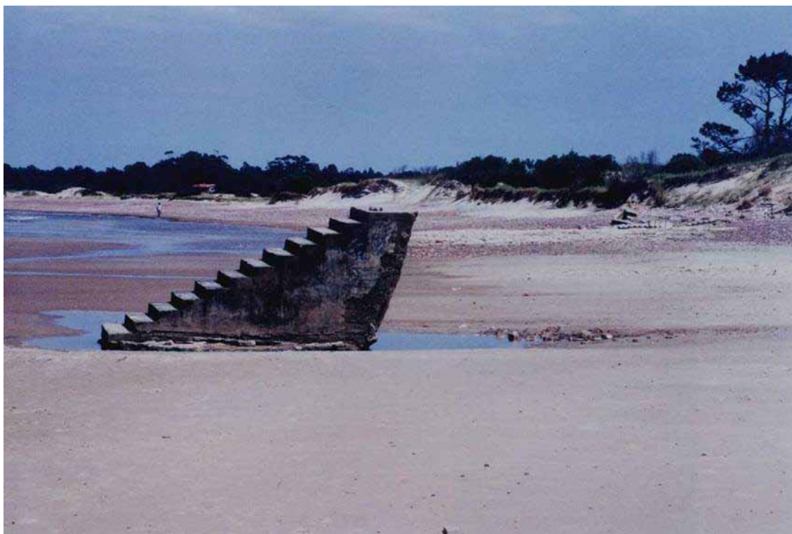
Erosión de la playa de Solís (Maldonado). La escalera de hormigón muestra dónde se encontraba antiguamente la bajada a la playa. Foto: gentileza de UNCIEP, Facultad de Ciencias, Universidad de la República.
